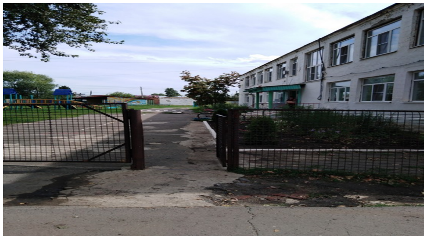
Вход на территорию ДОУ
